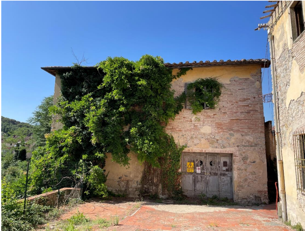
Figura 3 – Facciata laterale dell'edificio B
