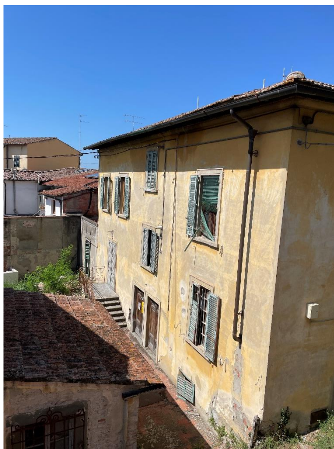
Figura 2 – Prospetto tergale dell'edificio A
