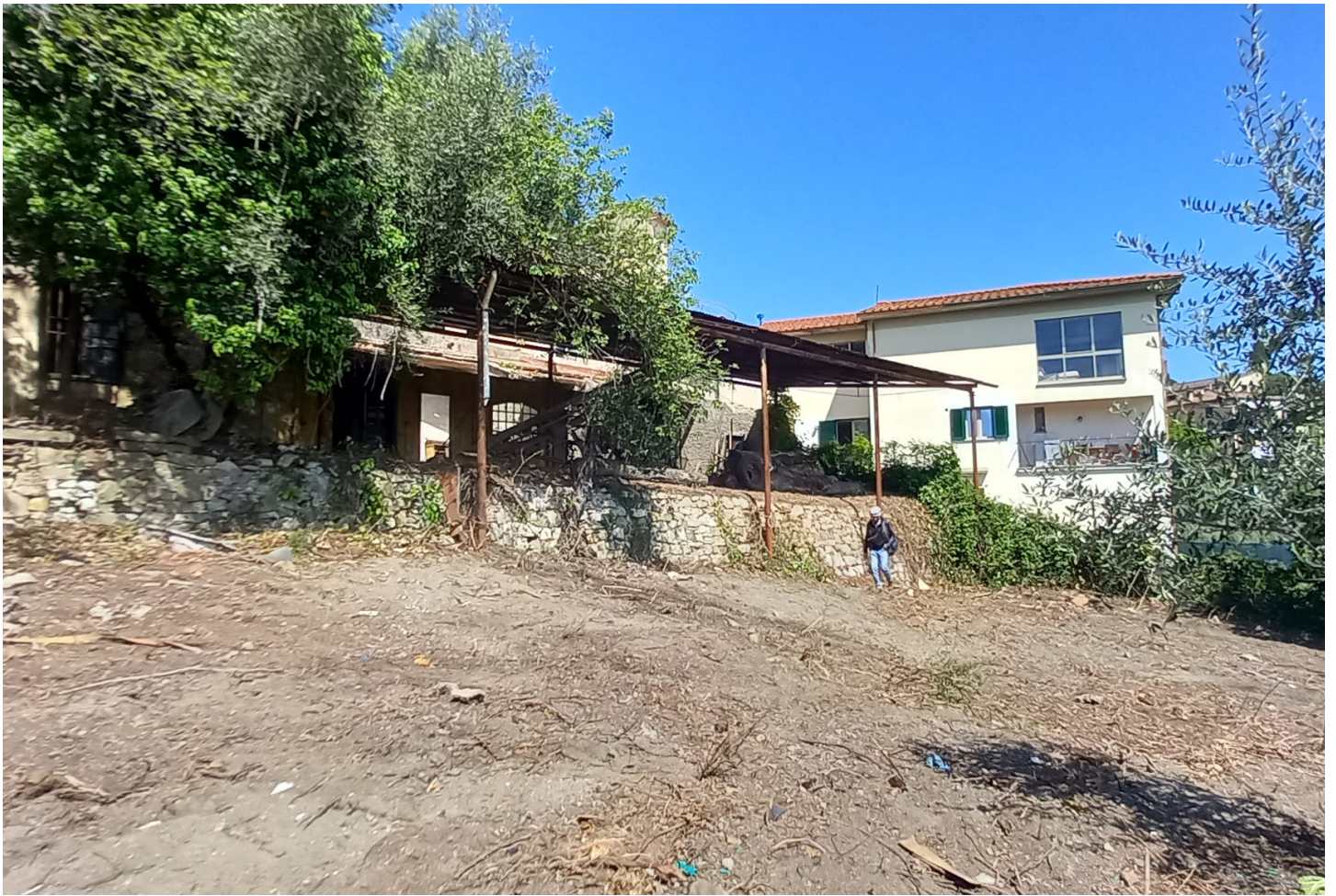
Foto 64 - Piano terra - Edificio E
