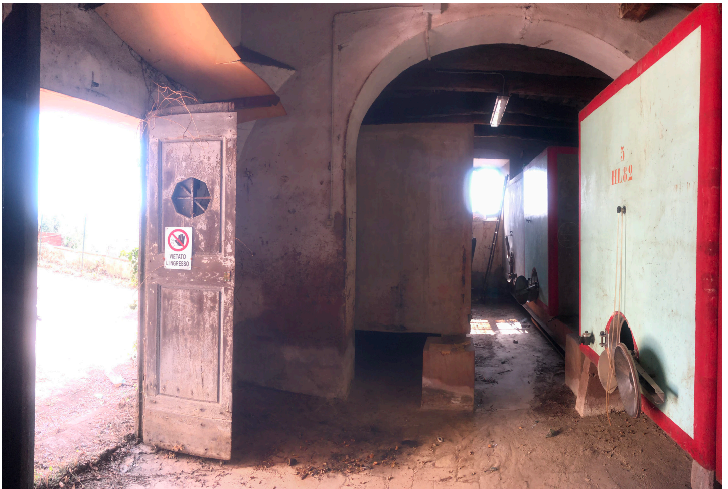
Foto 28 - Piano terra - Edificio B
