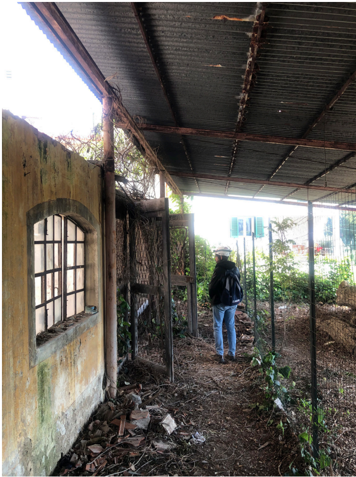
Foto 66 - Piano terra - Edificio E
