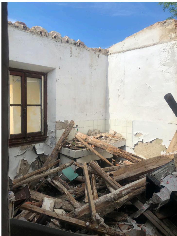
Foto 57 - Piano primo - Edificio C
