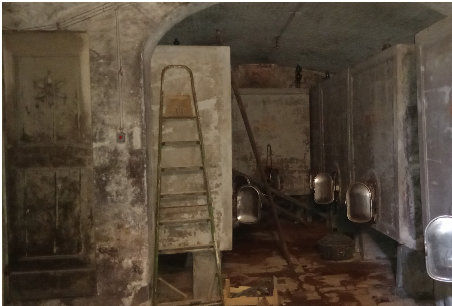
Foto 19 - Piano interrato - Edificio A
