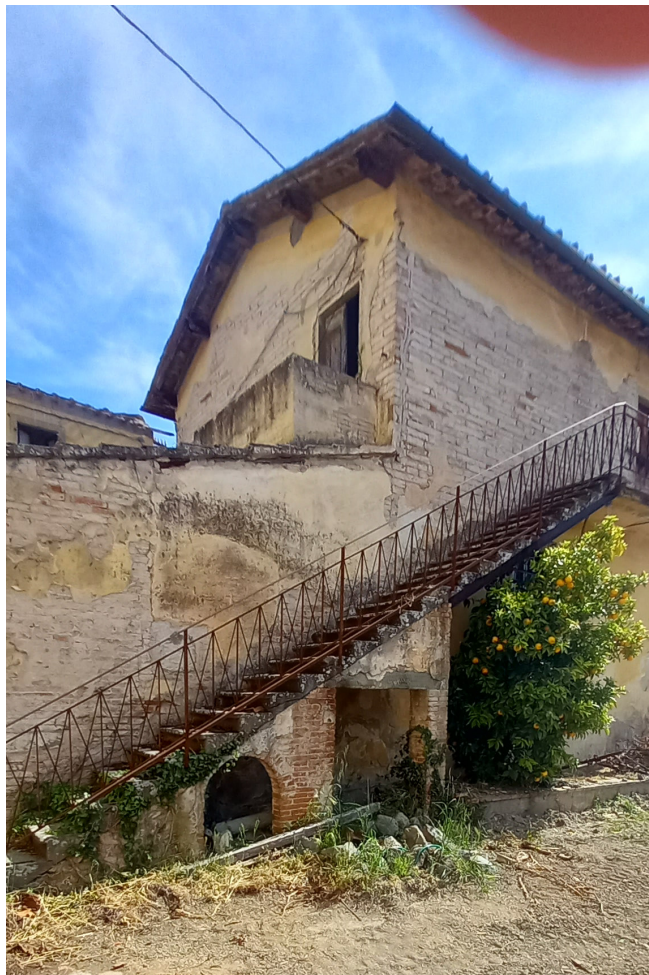
Foto 20 - Piano terra - Edificio B
