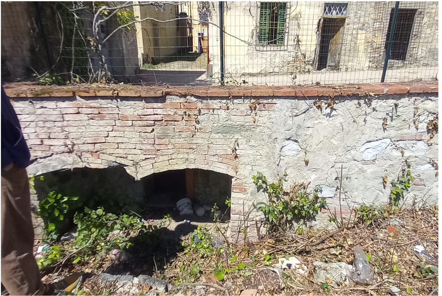
Foto 68 - Piano terra - Deposito interrato
