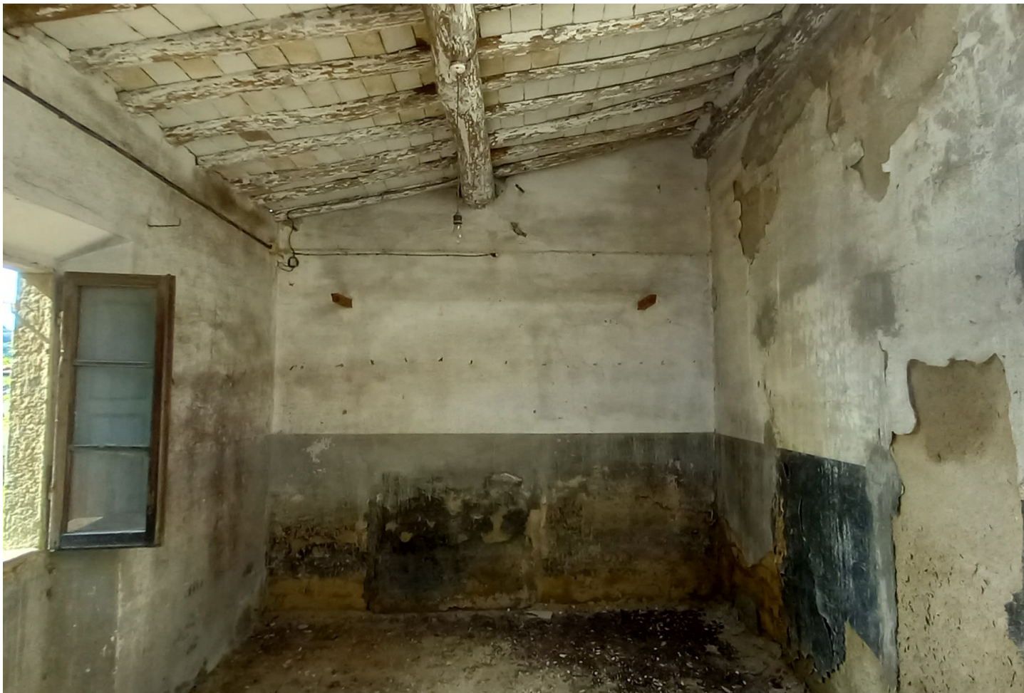
Foto 56 - Piano primo - Edificio C
