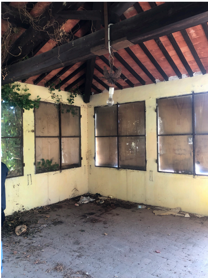
Foto 31 - Piano primo - Edificio B
