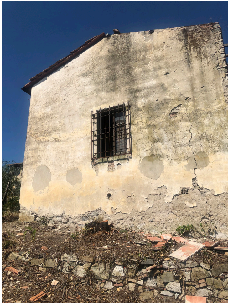
Foto 60 - Piano terra - Edificio D
