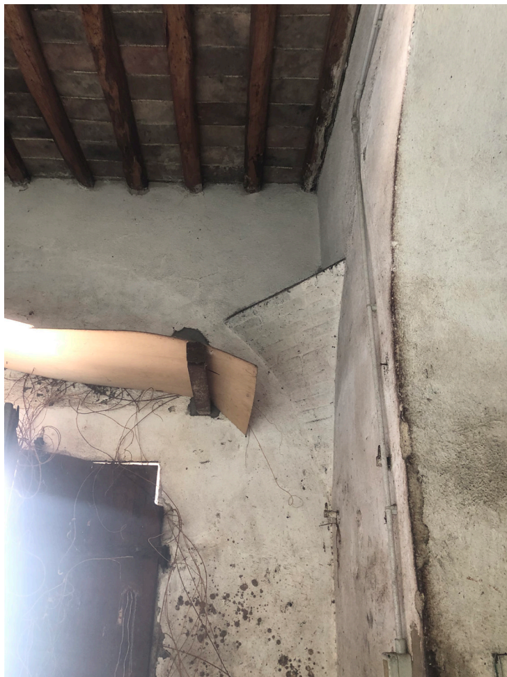
Foto 29 - Piano terra - Edificio B
