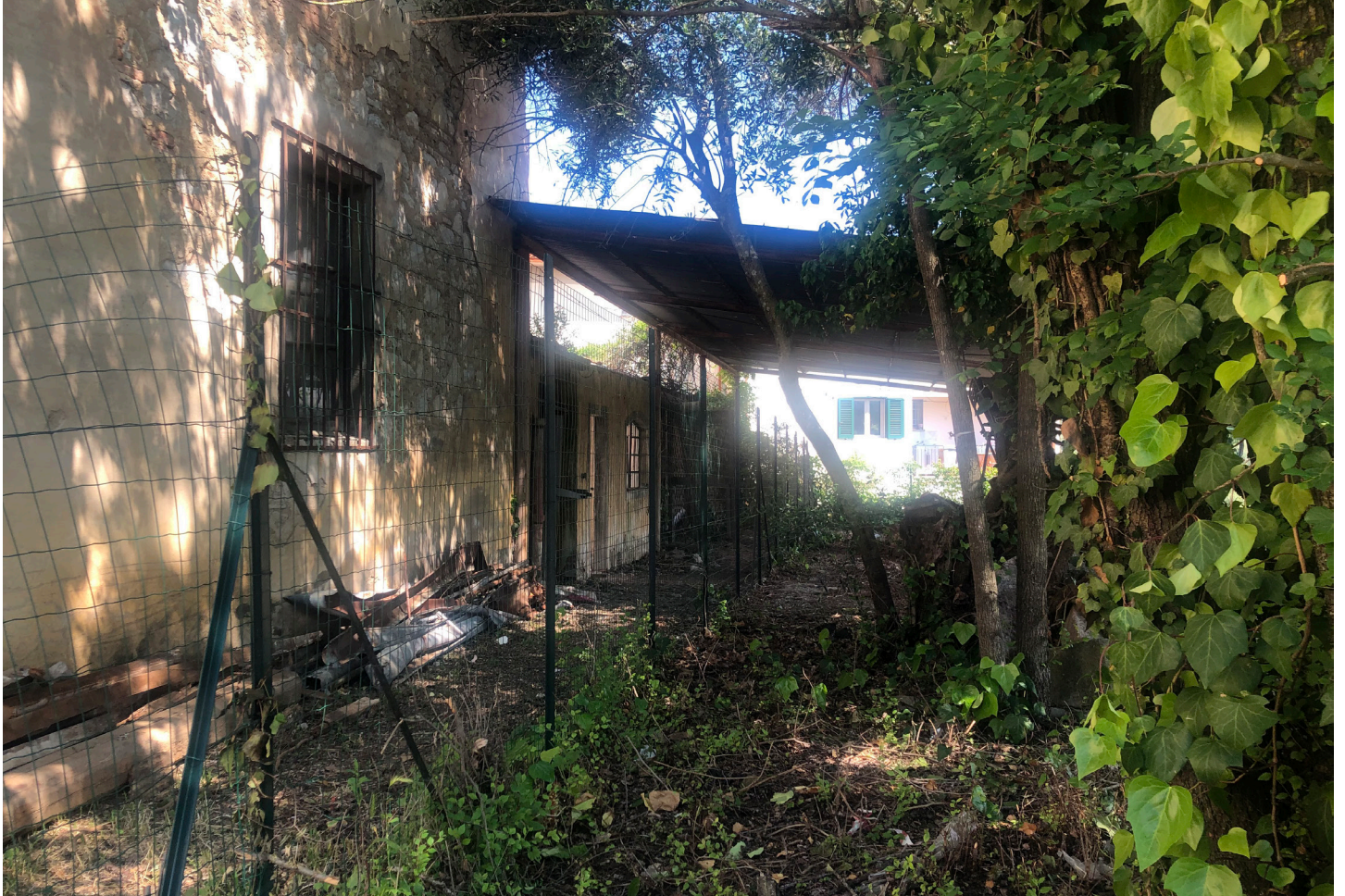
Foto 65 - Piano terra - Edificio E
