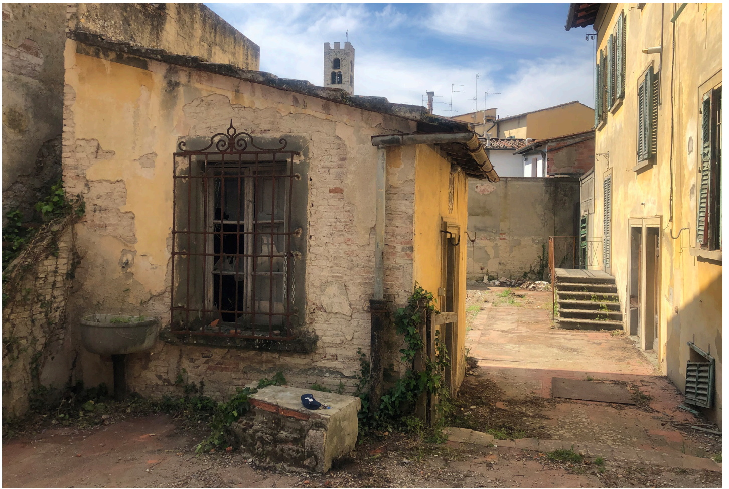
Foto 24 - Piano terra - Edificio B
