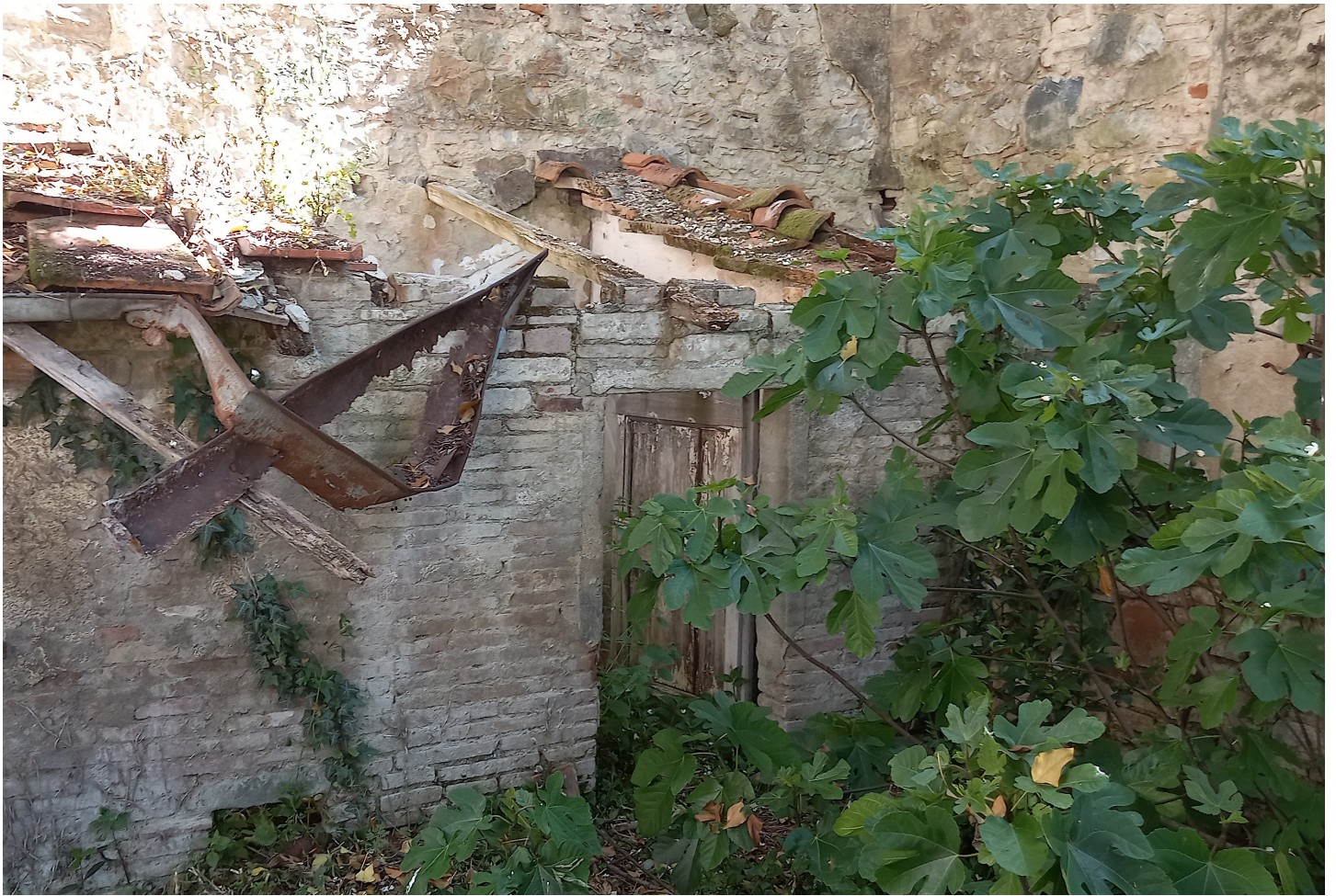
Foto 72 - Piano terra - Annessi
