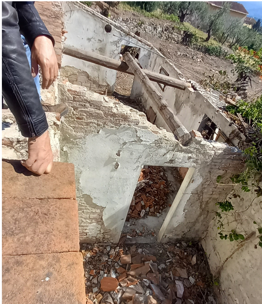
Foto 71 - Piano terra - Annessi
