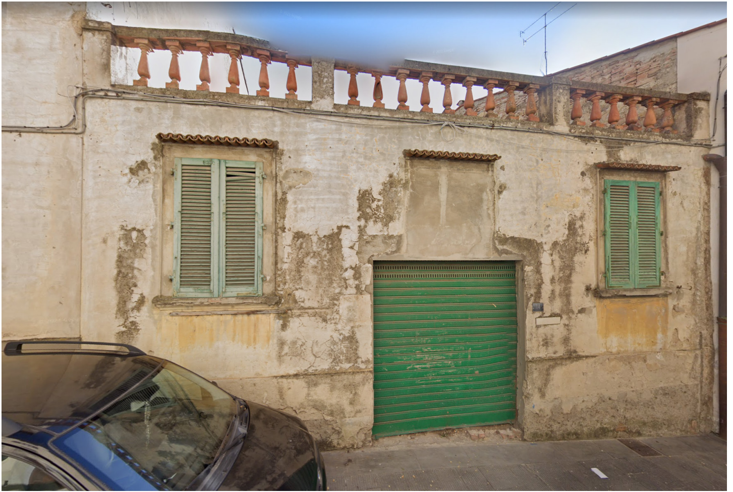
Foto 15 - Piano terra - Edificio A
