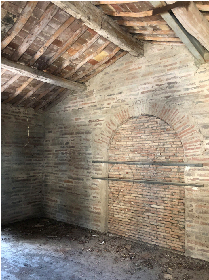
Foto 30 - Piano primo - Edificio B
