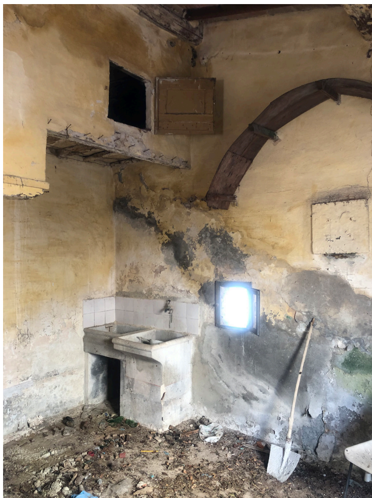
Foto 27 - Piano terra - Edificio B
