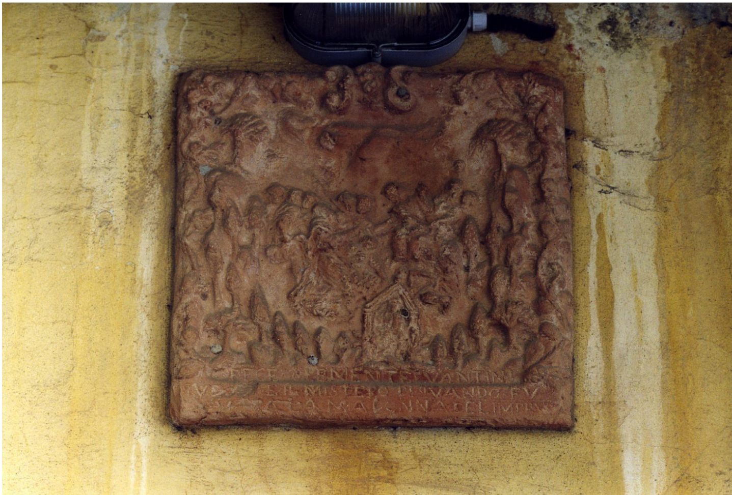
Foto 26 - Piano terra - Edificio B
