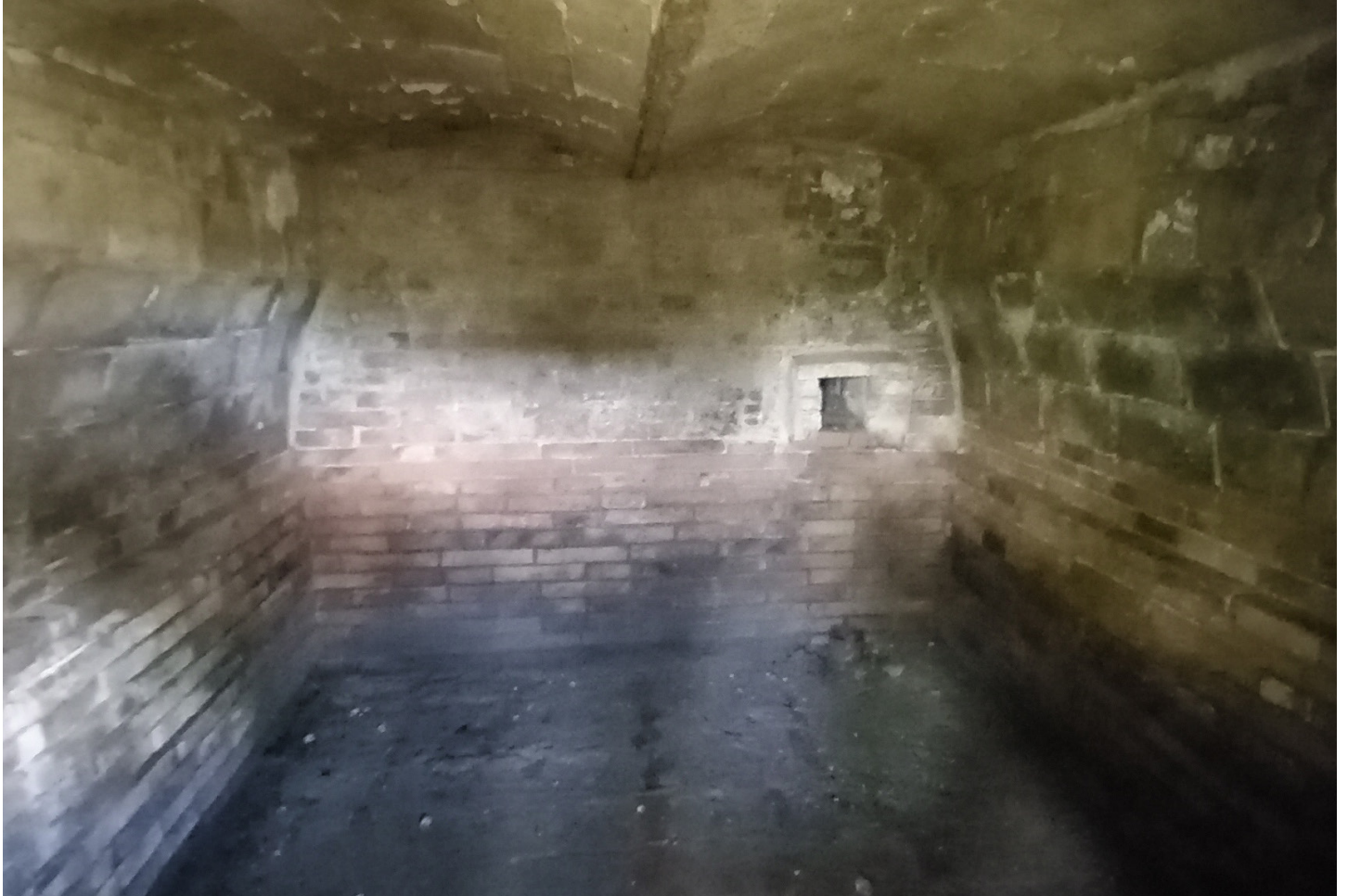
Foto 69 - Piano terra - Deposito interrato
