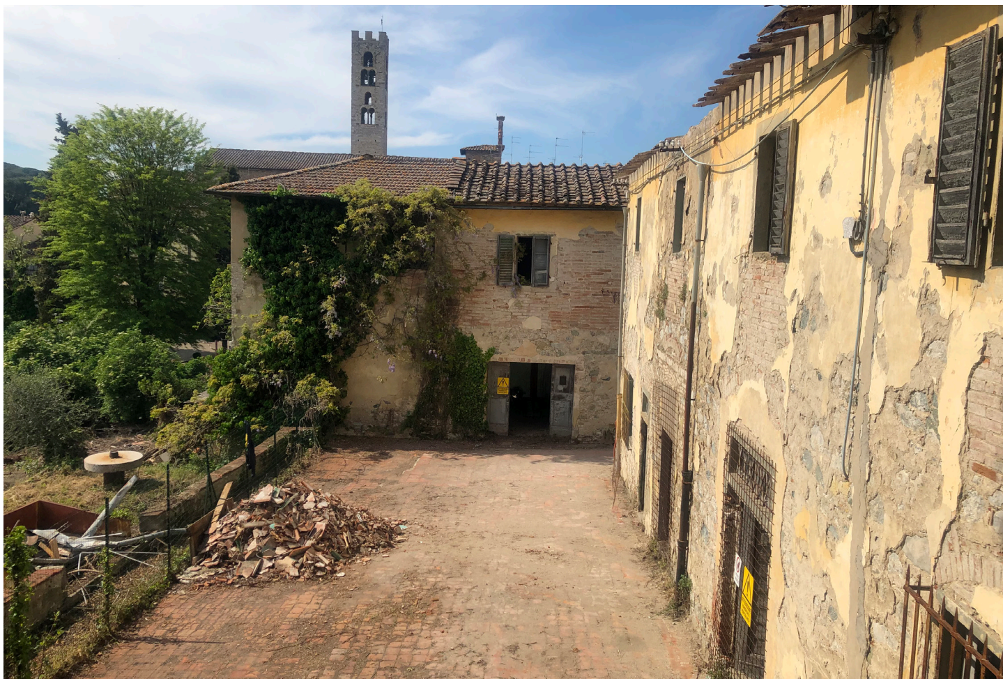
Foto 23 - Piano terra - Edificio B
