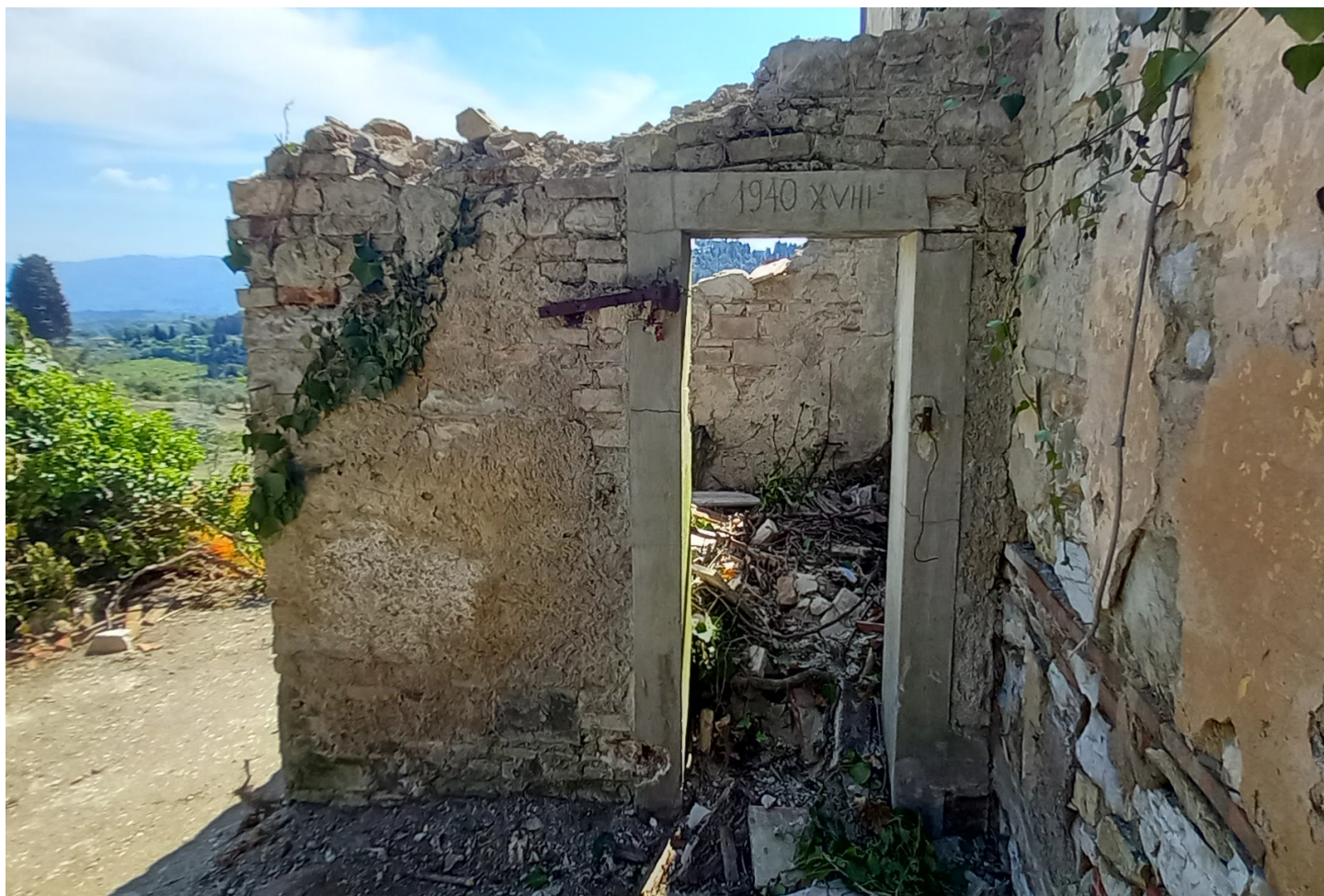
Foto 63 - Piano terra - Edificio D
