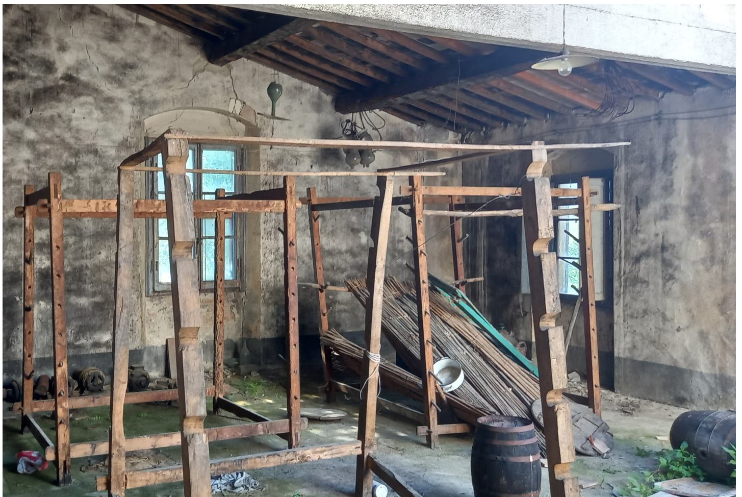
Foto 53 - Piano primo - Edificio C
