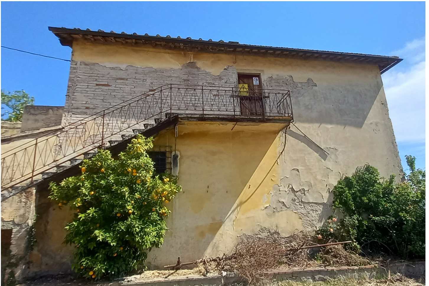
Foto 21 - Piano terra - Edificio B
