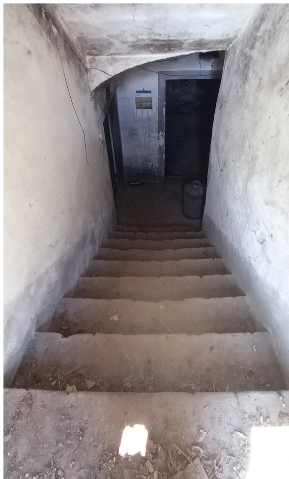
Foto 16 - Piano interrato - Edificio A
