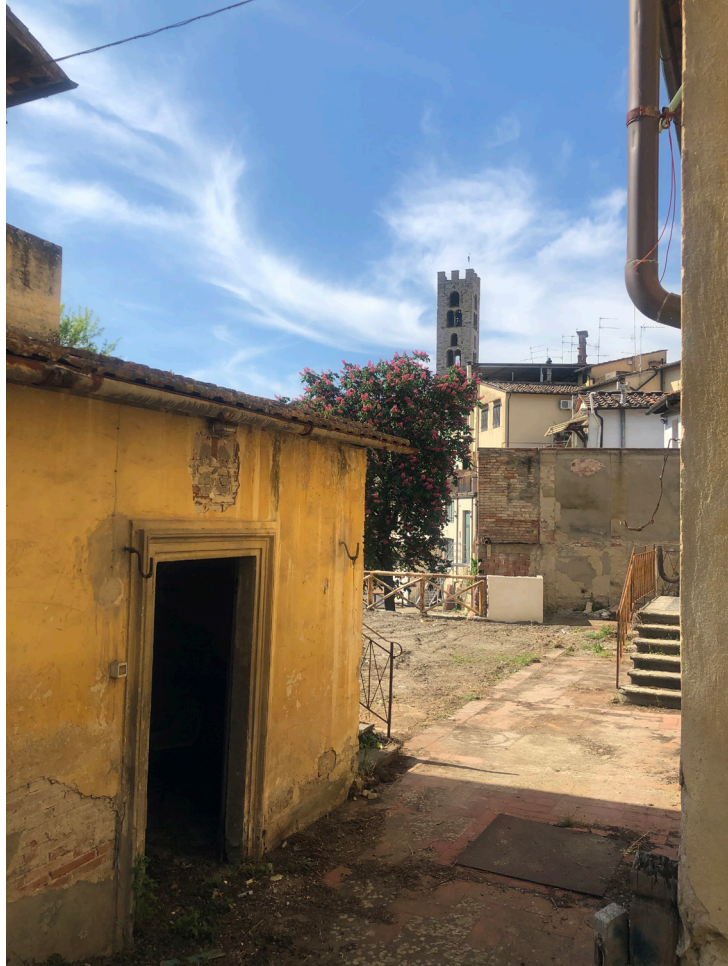
Foto 25 - Piano terra - Edificio B
