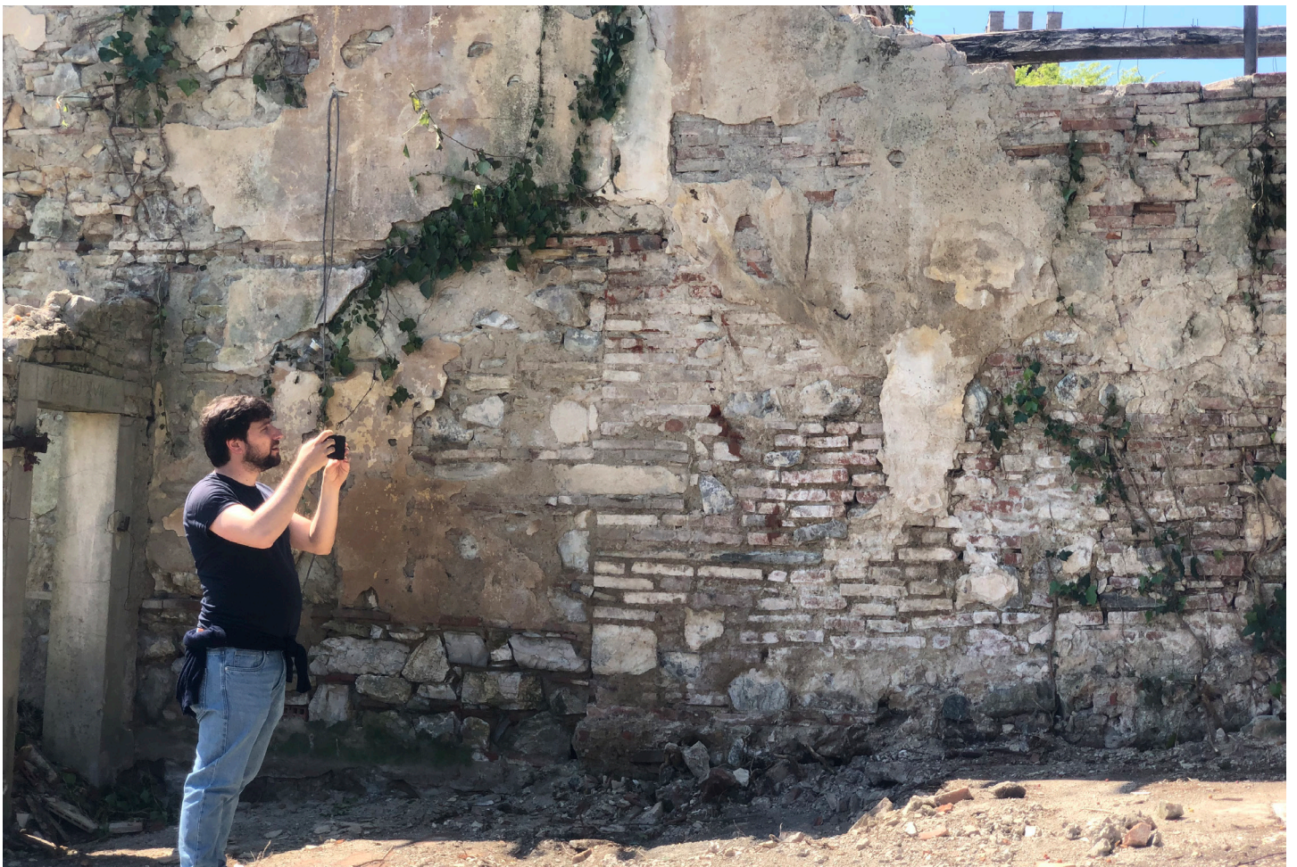
Foto 62 - Piano terra - Edificio D
