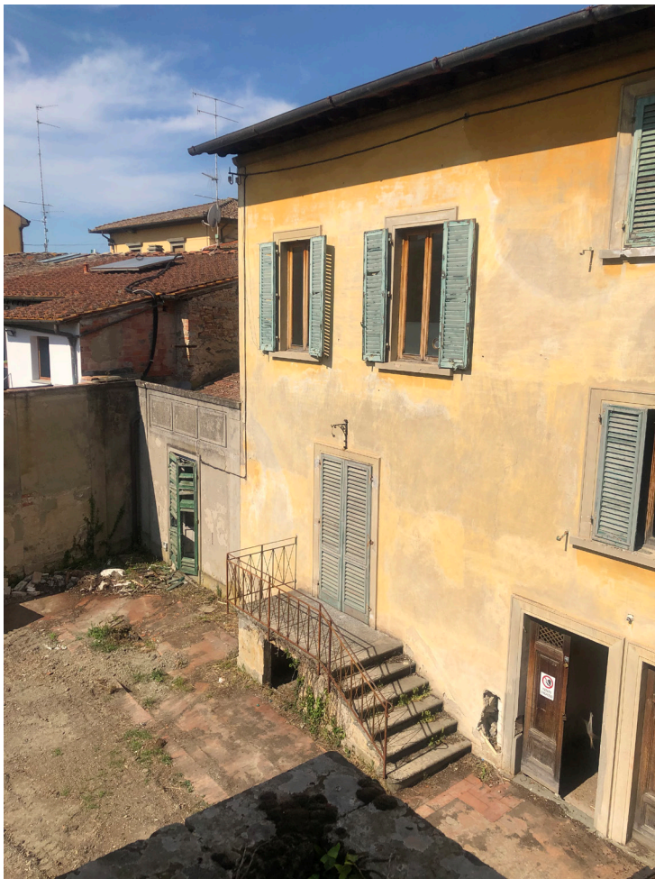
Foto 15 - Piano terra - Edificio A
