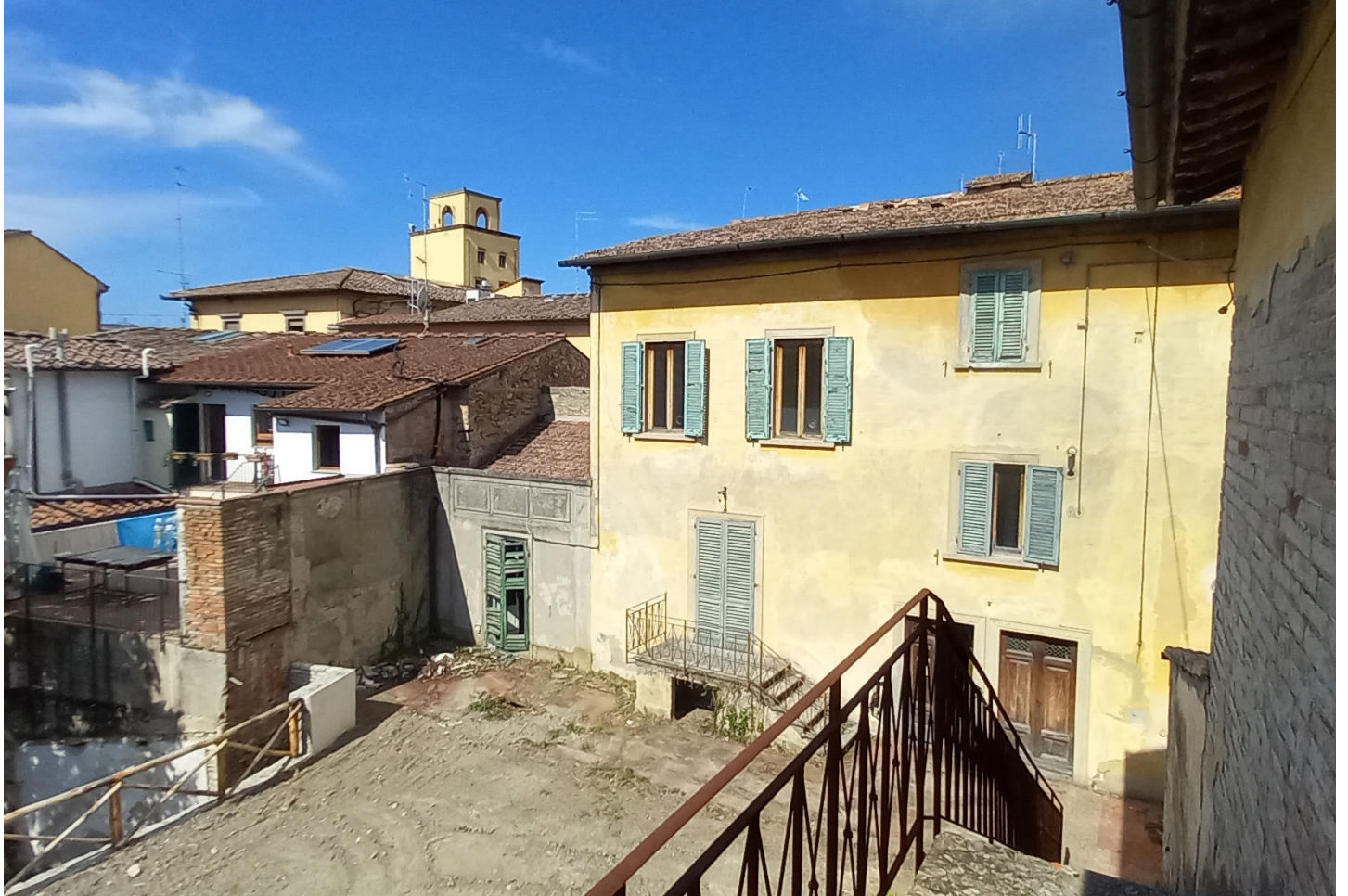
Foto 14 - Piano terra - Edificio A
