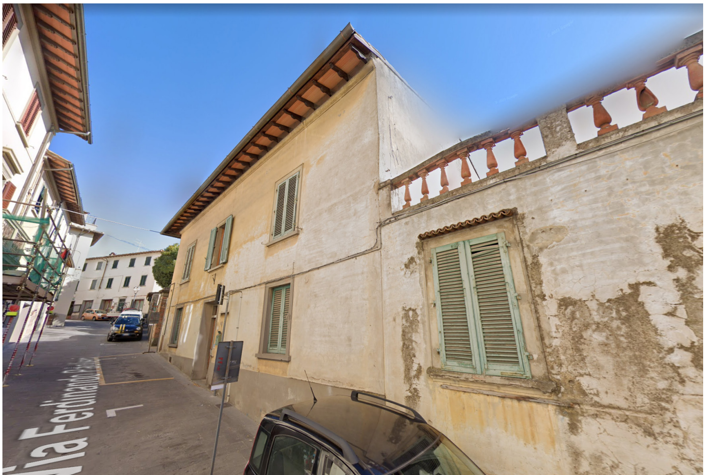
Foto 16 - Piano terra - Edificio A
