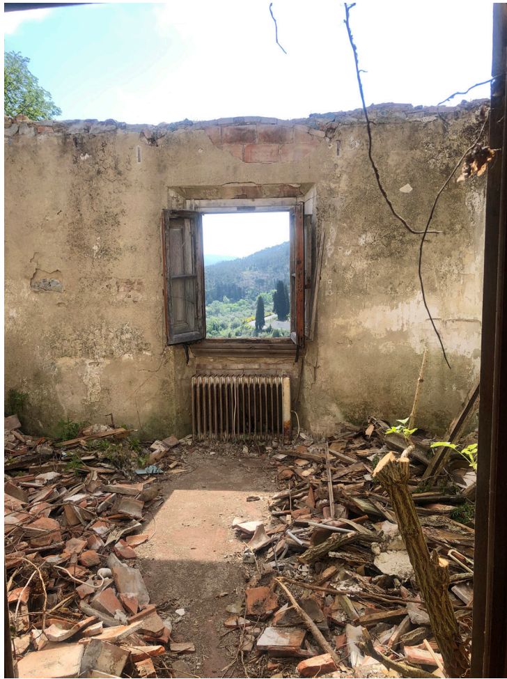
Foto 58 - Piano primo - Edificio C
