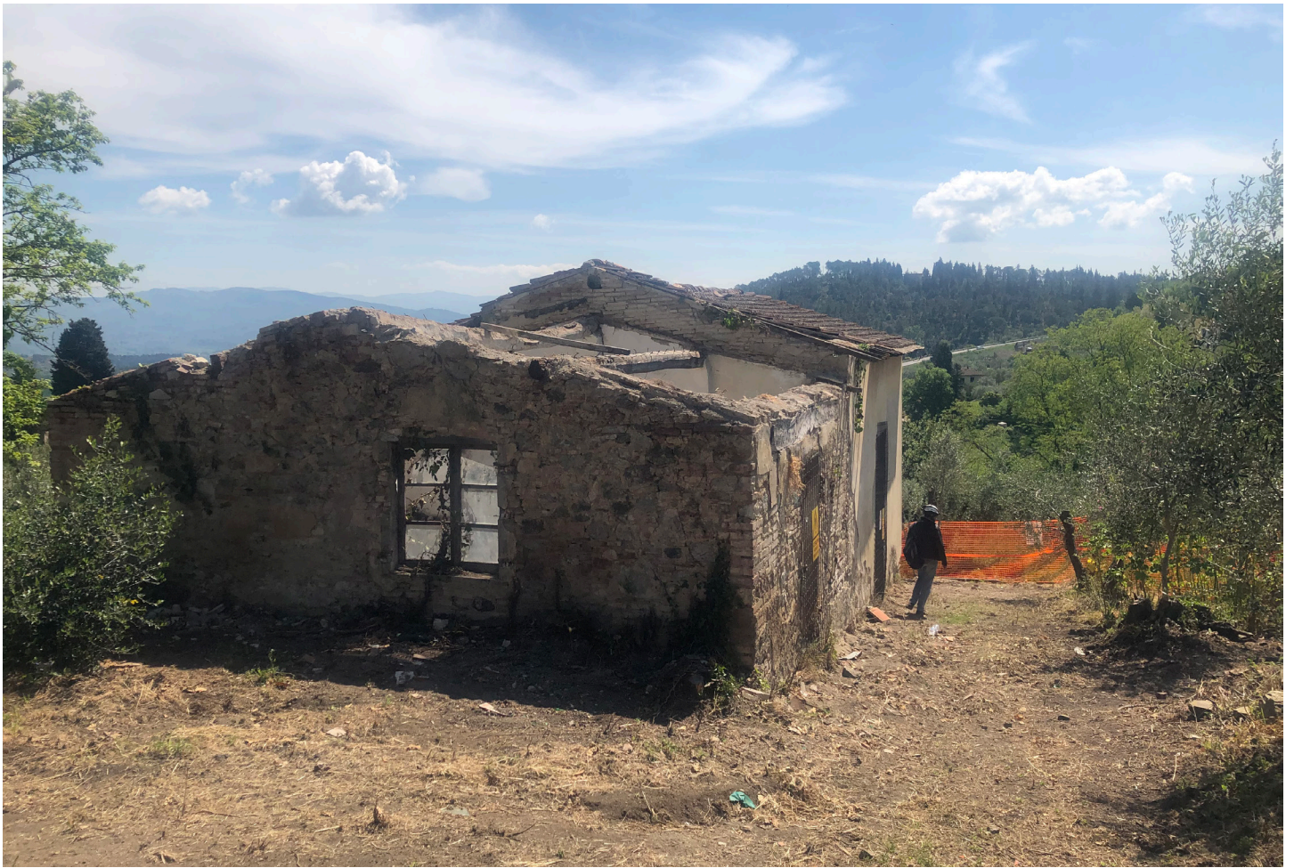
Foto 59 - Piano terra - Edificio D
