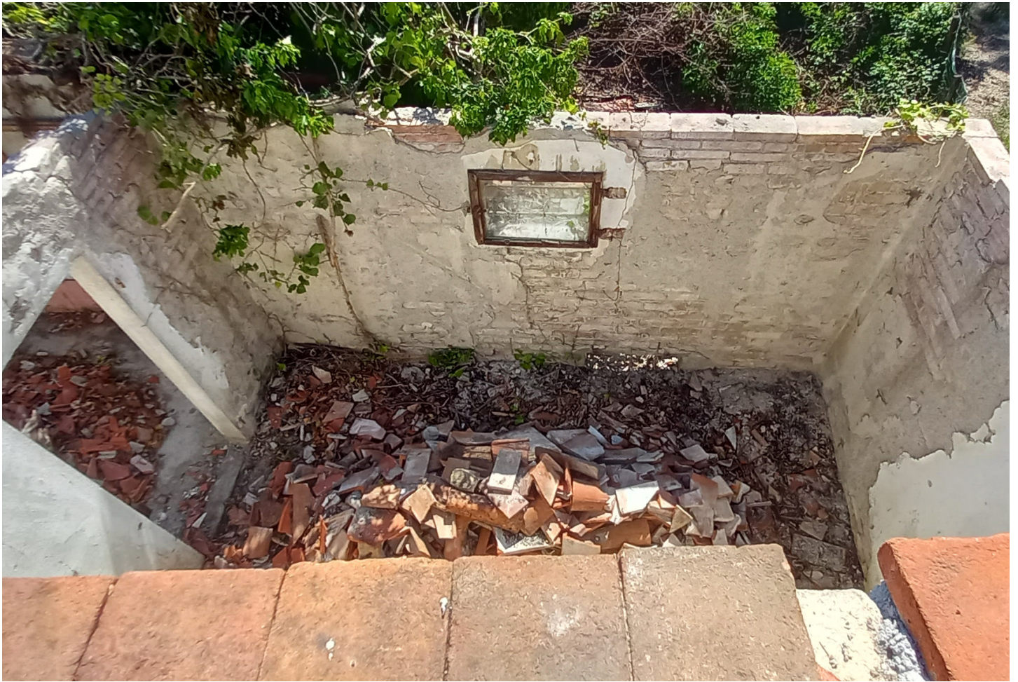
Foto 70 - Piano terra - Annessi
