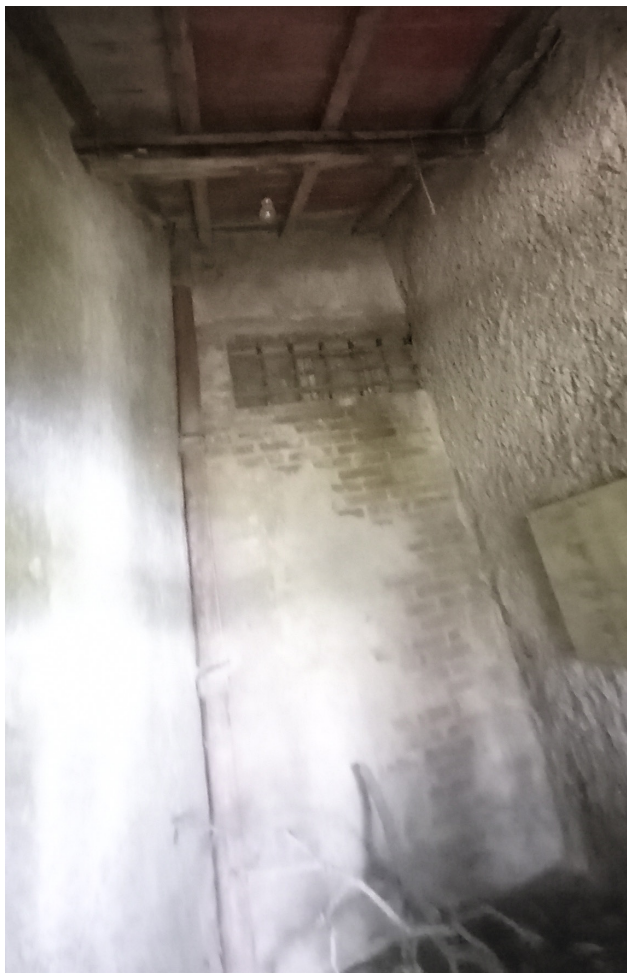
Foto 74 - Piano terra - Annessi
