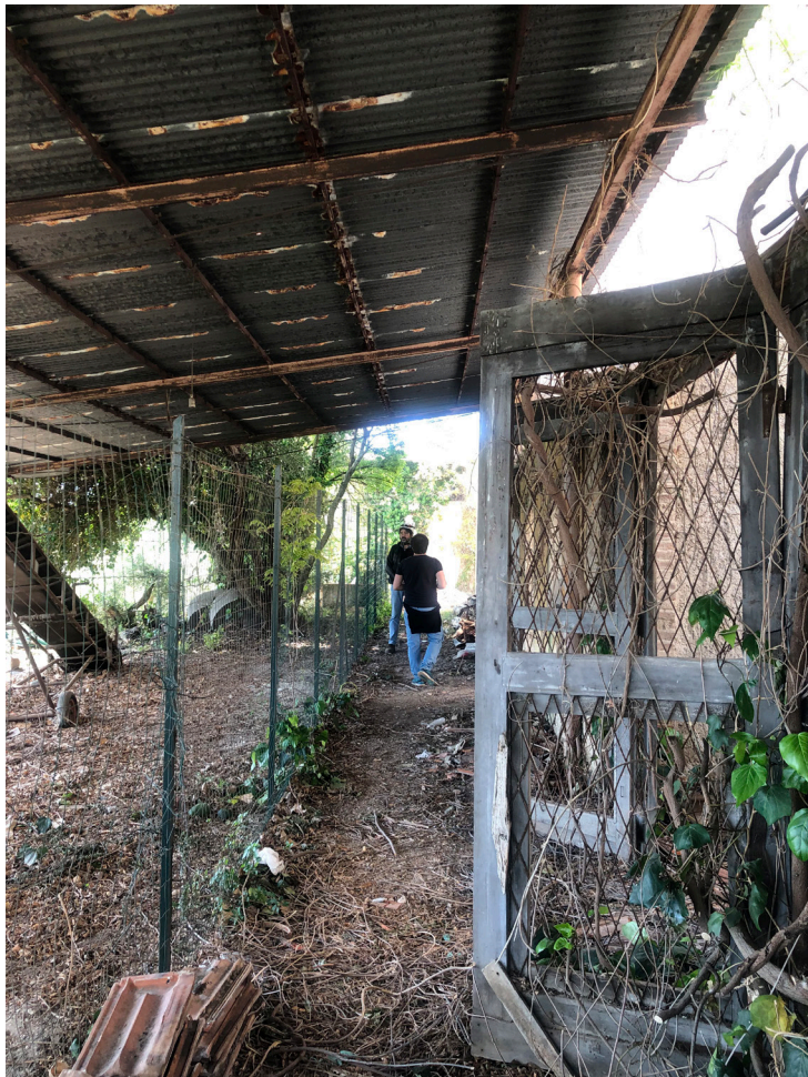
Foto 67 - Piano terra - Edificio E
