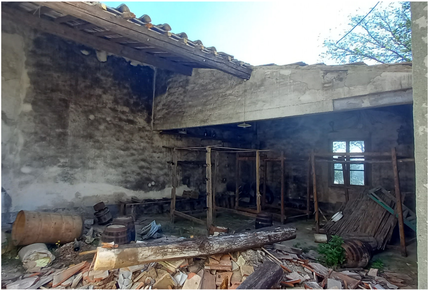
Foto 54 - Piano primo - Edificio C
