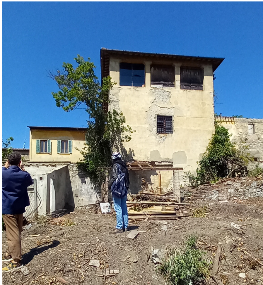
Foto 22 - Piano terra - Edificio B
