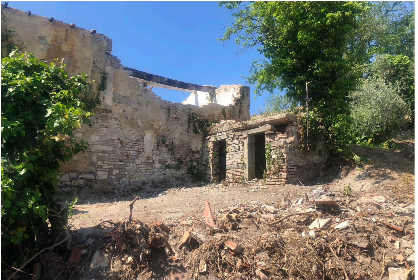
Foto 61 - Piano terra - Edificio D
