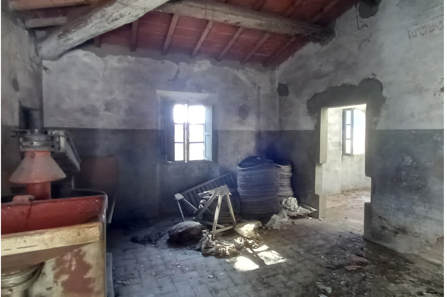
Foto 55 - Piano primo - Edificio C
