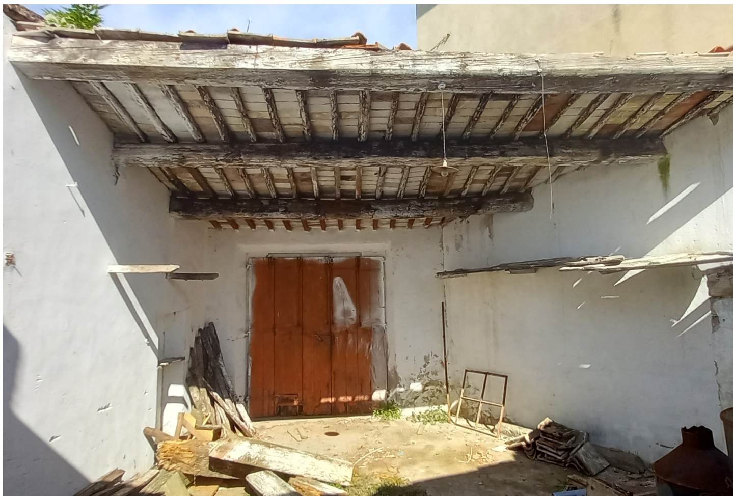
Foto 51 - Piano primo - Edificio C
