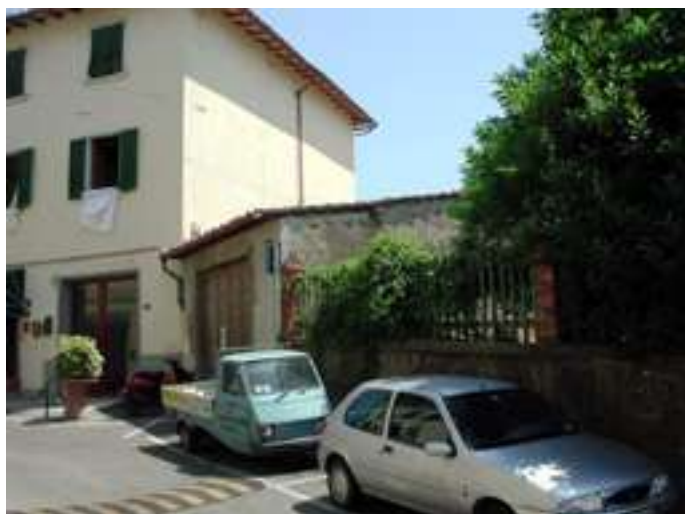
Prospetto su Via Paolieri
