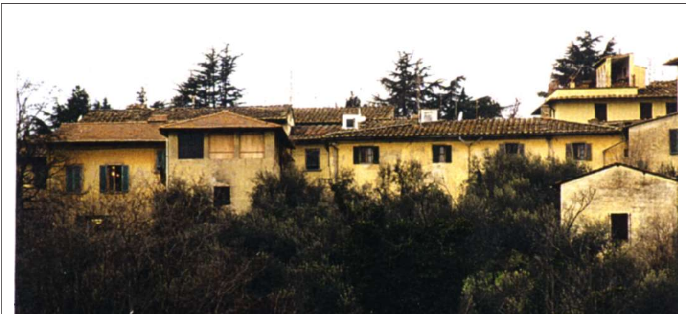
I prospetti a valle del complesso colonico
