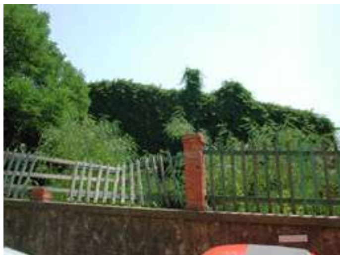
Prospetto su Via Paolieri
