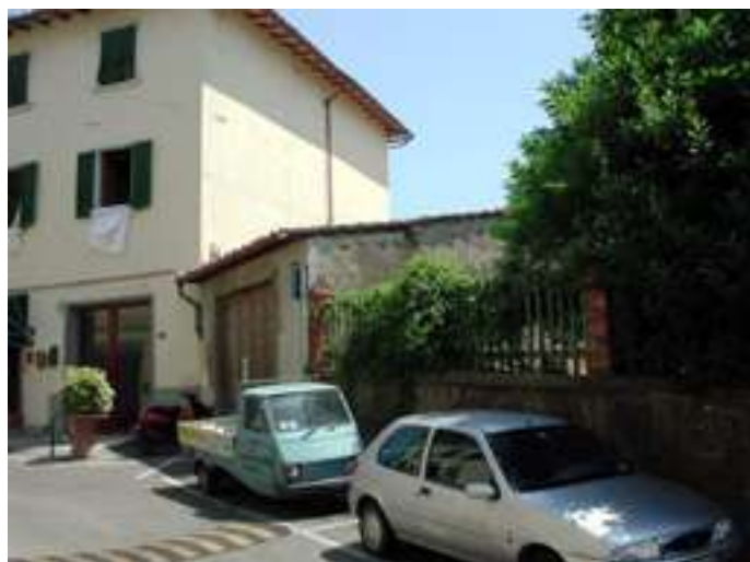
Prospetto su Via Paolieri
